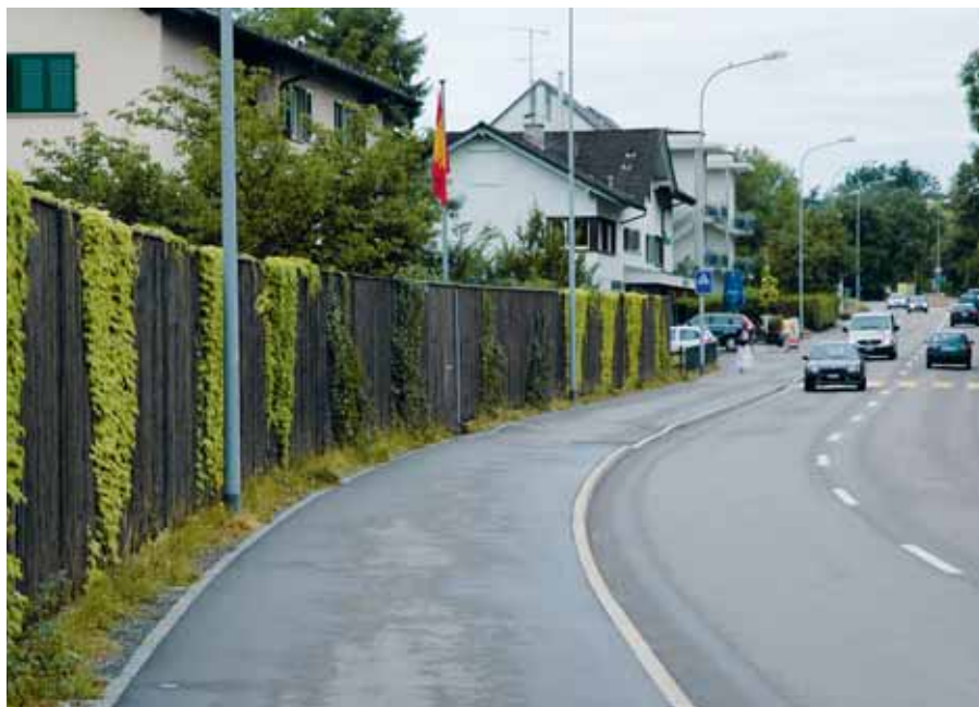
Lärmschutzwände bilden Strassenschluchten und animieren eher zu lärmigem Fahren, Reflexionen an Dachkanten und Traufen der dahinter liegenden Gebäude reduzieren ausserdem die Wirkung von Lärmschutzwänden.
