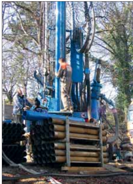
Bohrungen erfordern Fachleute und spezialisierte Gerätschaften.
