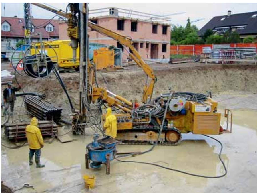
Erdwärmesondenanlagen sind bei Neubauten von Ein- und Mehrfamilienhäusern heute die häufigste Heizquelle.
