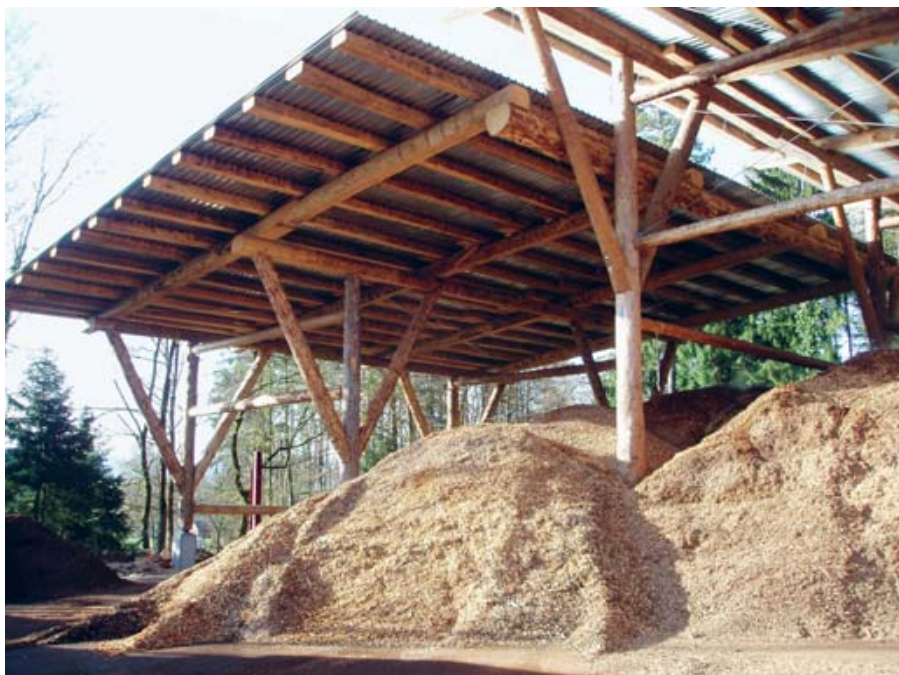
Die Nachfrage nach Stückholz und Holzschnitzeln ist sehr gross in der Region. 2010 wurde daher die neue Schnitzellagerhalle des Energieholzzentrums Pfannenstiel in Betrieb genommen. Quelle: Genossenschaft Holznutzung Pfannenstiel
