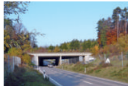
Die beiden Überführungen Rütibuck (oben) und Loterbuck (unten) sollen helfen, die Barrierewirkung von Strassen zu reduzieren.
