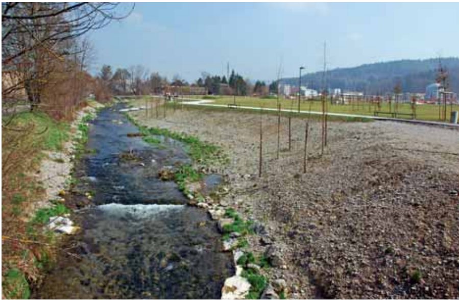
Revitalisierte Eulach im Bereich Eulachpark, Neuhegi: Auf einer Strecke von rund 500 Metern hat die Stadt die zuvor befestigte Flusssohle entfernen lassen, die steilen Uferböschungen teilweise abgeflacht und mit standortgerechten Gehölzen, Hochstauden und einer artenreichen Wiesensaatmischung bepflanzt.
