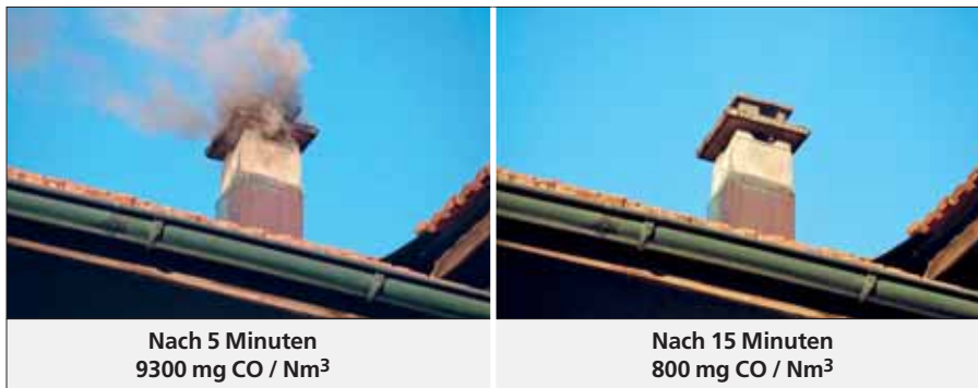
Visuelle Rauchbildkontrolle: 15 Minuten nach dem Anfeuern muss ein rauchfreier Betrieb erreicht werden, sonst wird der Kohlenmonoxid-Emissionsgrenzwert der Luftreinhalte-Verordnung (von 4000 mg/Nm 3 ) nicht eingehalten.
