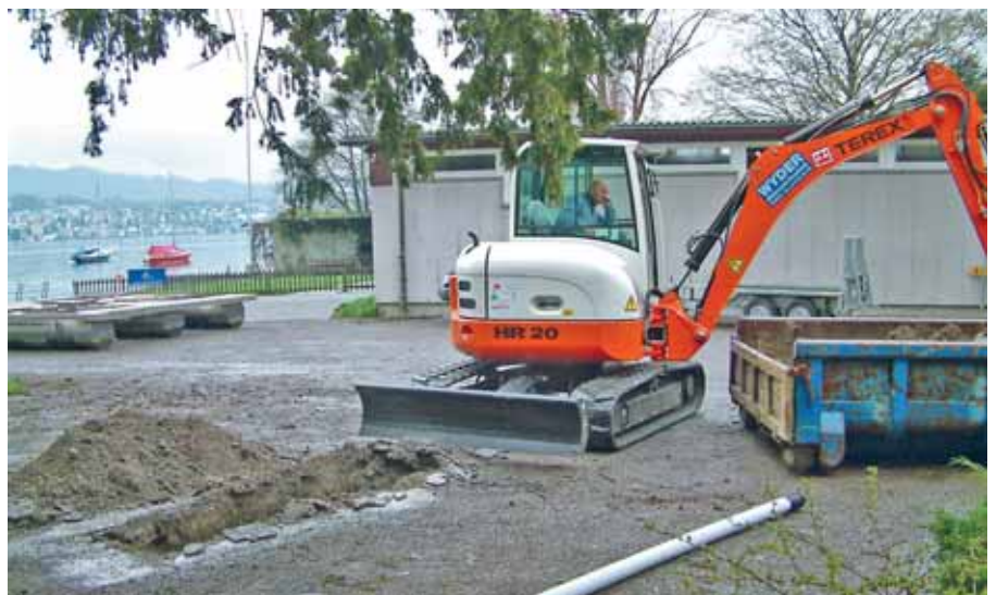
Erste Erkundung der Seeuferauffüllung Widen mit einem Baggerschlitz.
