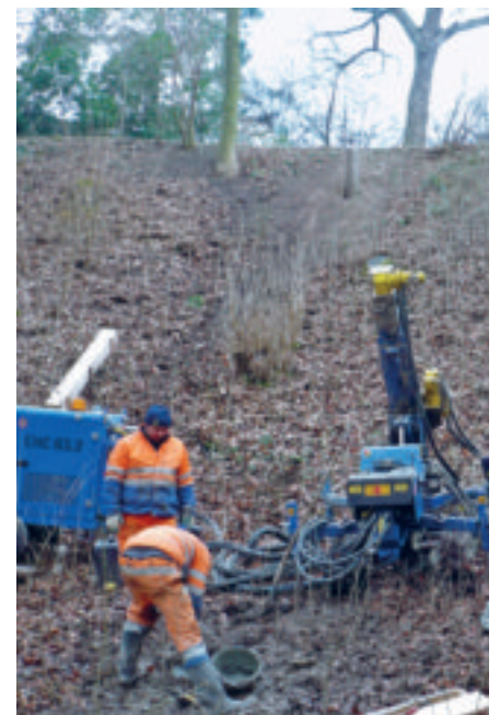
Abtiefen einer Bohrung am Fuss der Deponie Rossbächli mit anschliessendem Ausbau als Sickerwassermessstelle.
