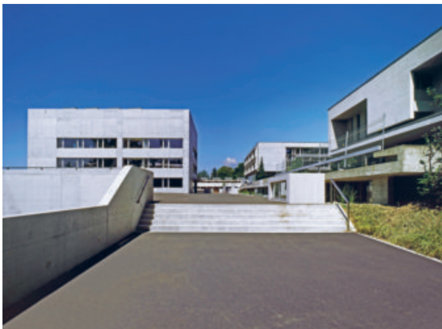
Bei der Kantonsschule Rychenberg – einer von drei öffentlichen Minergie-Bauten in Winterthur – wurden bereits viele Kriterien des Minergie-Eco-Standards berücksichtigt.
