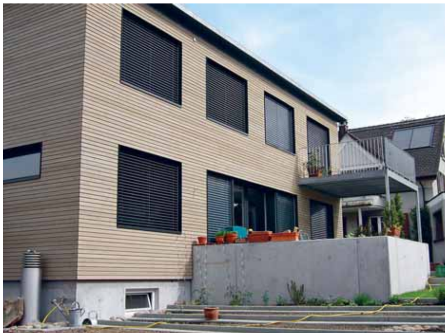
Mit Lamellen als aussenliegendem Sonnenschutz wird der Überhitzung von Gebäuden – auch bei Wohnbauten – entgegengewirkt.
