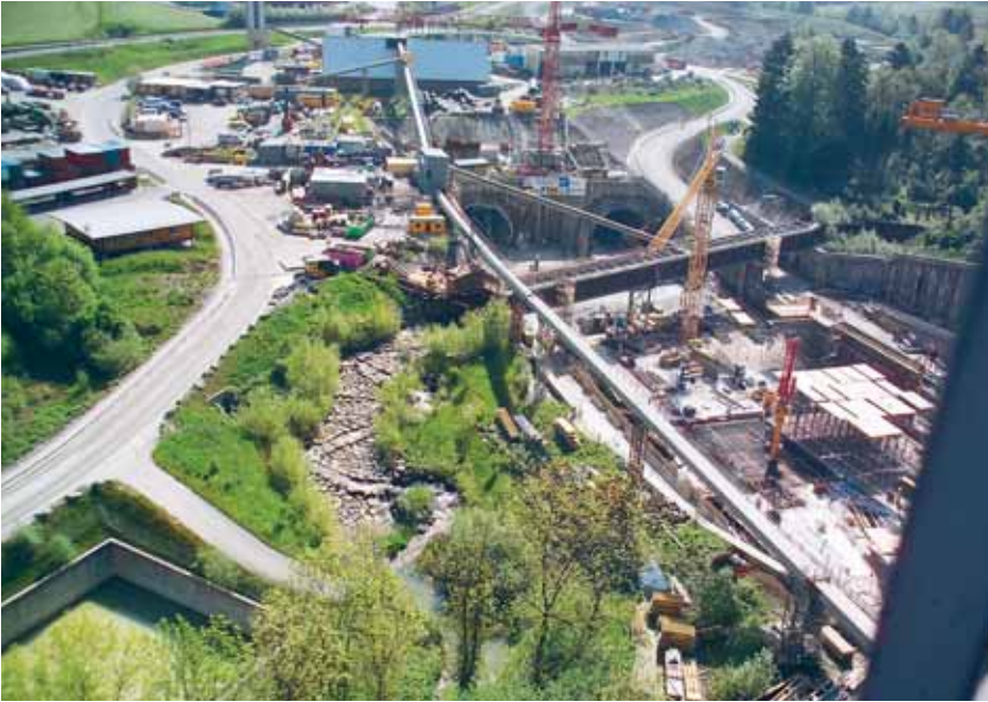
Revitalisierungen sind heute oft als Teil grösserer Bauprojekte möglich, hier die fischgängige Rampe der grossen Uetliberg-Baustelle in Landikon.
