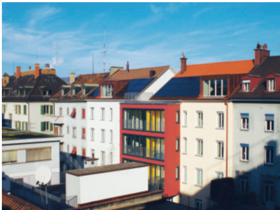
Eine Gebäudemodernisierung mit energetischen Verbesserungen bringt mehr Komfort, tiefere Betriebskosten und einen Gewinn für die Umwelt.
