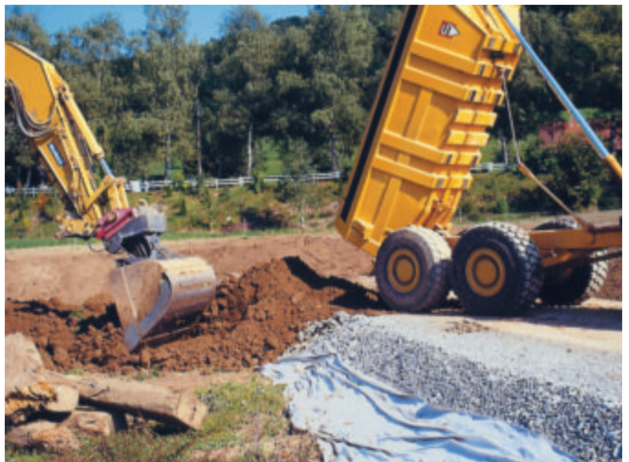
Arbeitstechniken bei Bodenrekultivierungen: Angeführter Oberboden wird mit dem Bagger verteilt.
