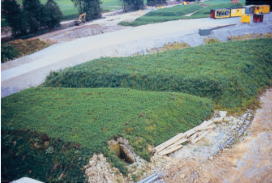
Begrüntes Zwischenlager von Oberboden.
