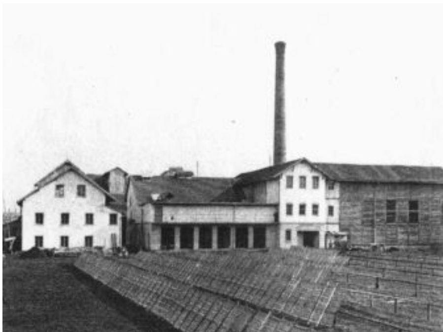
Auf alten Fabrikgeländen ist immer wieder mit unangenehmen Überraschungen zu rechnen.
