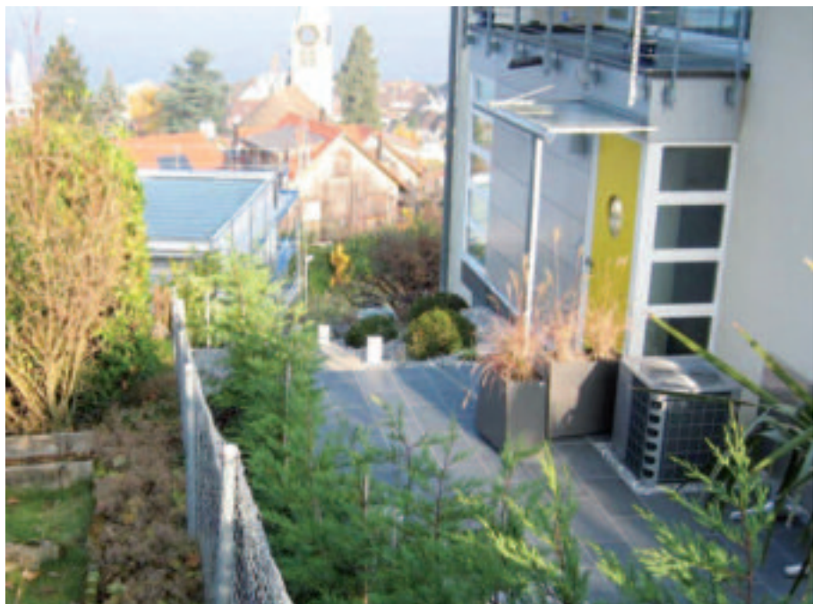
Durch den Lärm einer Wärmepumpe (rechts im Bild) kann eine schöne Wohnlage in ihrer Qualität gemindert werden.
