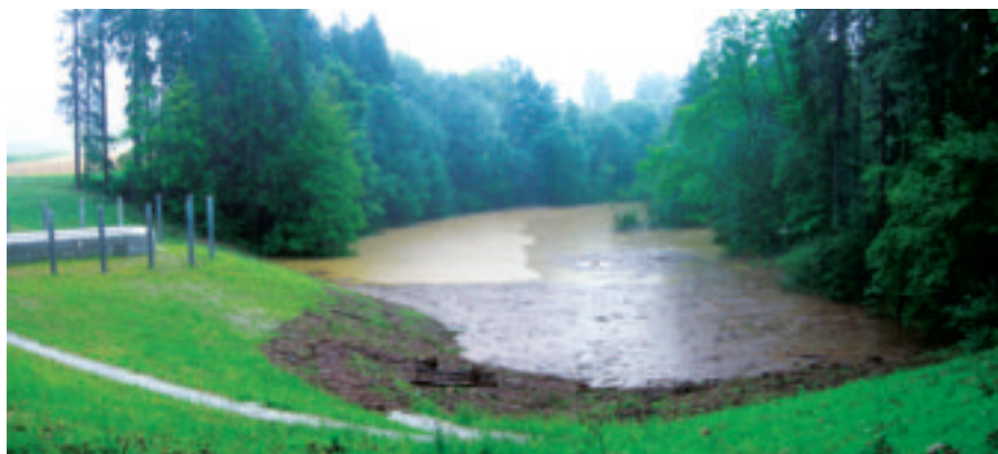
Hochwasser im August 2007: Dank des kurz vorher eingeweihten Rückhaltebeckens Jonenbach blieb Affoltern am Albis verschont. Der maximale Wasserstand während der vergangenen Nacht ist anhand der Ablagerungen deutlich sichtbar.
