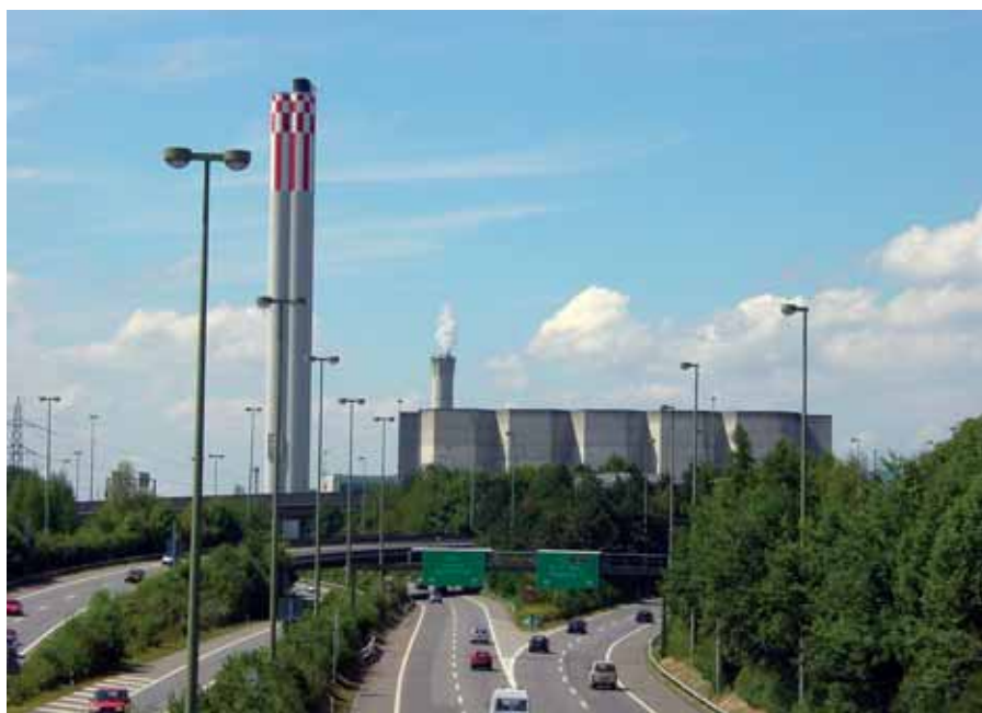
Fernwärme aus dem Kehrlichtverbrennungsprozess wird beispielsweise im Universitätsspital Zürich in Form von Dampf zum Sterilisieren von Operationsinstrumenten sowie zum Kochen von täglich 4500 Mahlzeiten verwendet.
