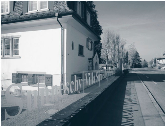
Sichtdurchlässige Lösungen von Lärmschutzfragen sind ansprechend. Allerdings sind dem Einsatz von Glas wegen der Schallreflexionen Grenzen gesetzt.
