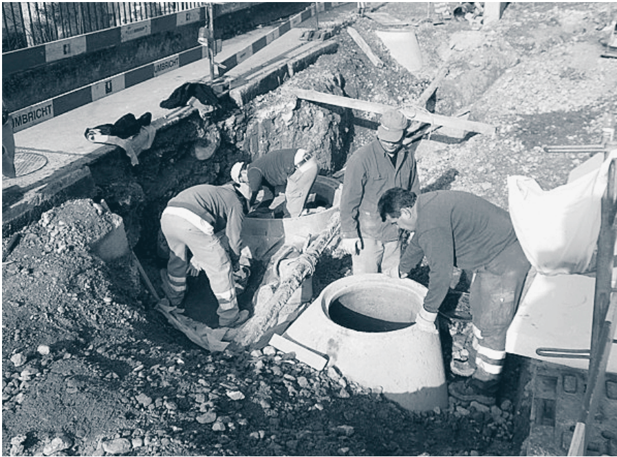
Misch- oder Trennsystem? Bevor Baustellenabwasser in diese Schächte abgeleitet wird, ist das abzuklären.
