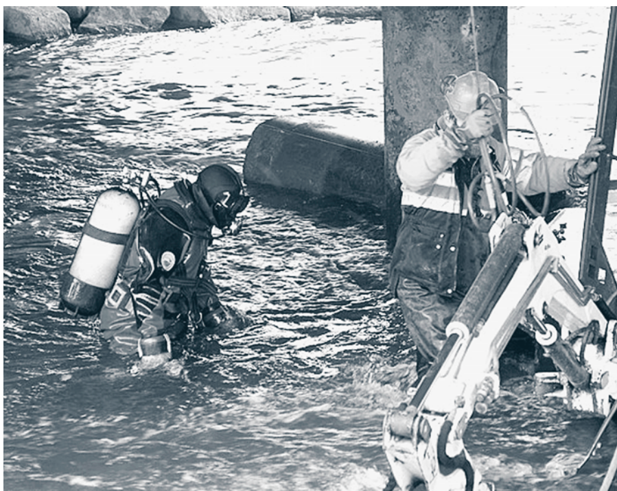
Beim Bauen in Gewässern ist erhöhte Sorgfalt angebracht, und es dürfen keine Fremdstoffe abgelagert oder wassergefährdende Flüssigkeiten eingebracht werden.
