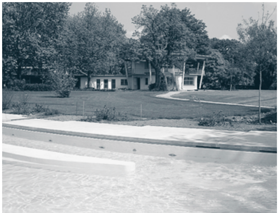
Im Rahmen der Sanierung der Badi Letzi wurde sämtlicher belasteter Boden ersetzt.
