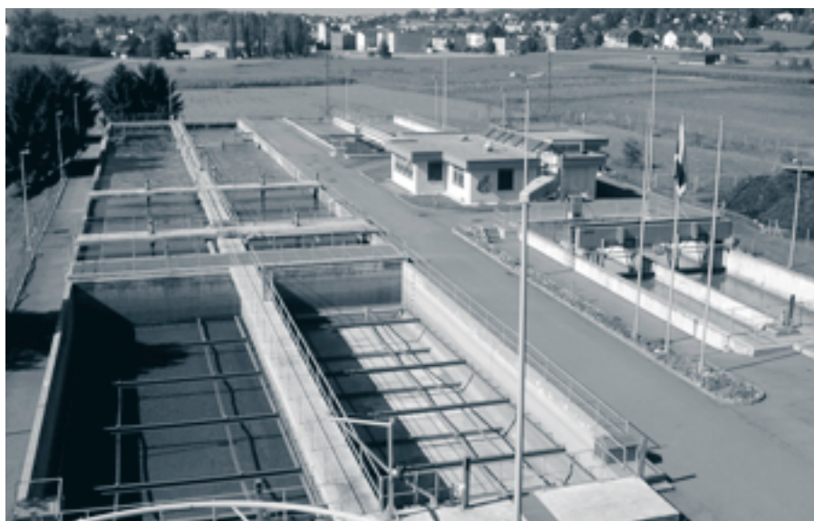
... wie auch für die Abwasserreinigung ist der GEP die planerische Grundlage.
