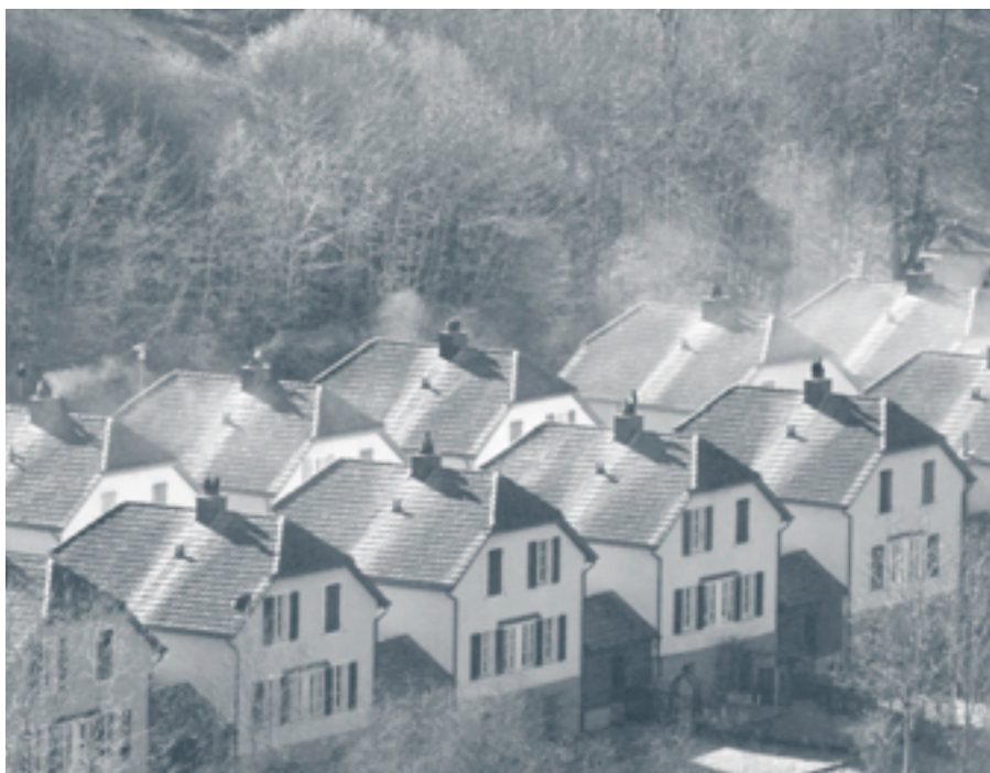
Rauchende Kamine sind ein Zeichen dafür, dass das Feuer nicht richtig brennt und unnötig Feinstaub emittiert.
