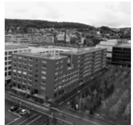
Die Standortdokumentation ist eine wesentliche Grundlage für sachliche Verhandlungen. Quelle: AWEL/Altlasten
