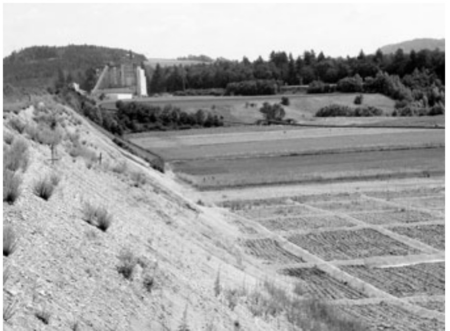
Kiesgrubengelände in verschiedenen Stadien der Rekultivierung: Im Vordergrund rechts mit freiliegender Drainage und noch ohne Oberboden.
