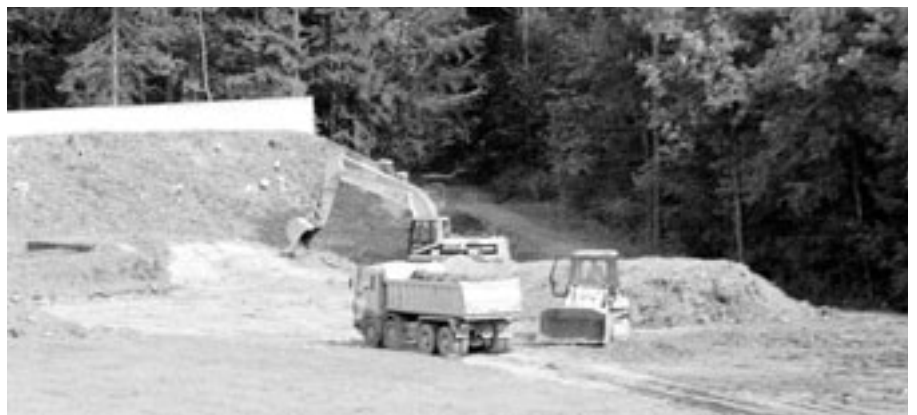
Kugelfänge an Schiessanlagen müssen – wie hier in Zürich Fluntern – aufwändig saniert werden. An die Entsorgung des bleibelasteten Aushubs zahlt der Bund unter gewissen Bedingungen bis zu 40 Prozent.
