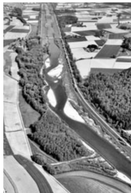
Zwischen Niederneunforn und Altikon hat die Thur bei einer Revitalisierung ausserdem mehr Platz bekommen.
