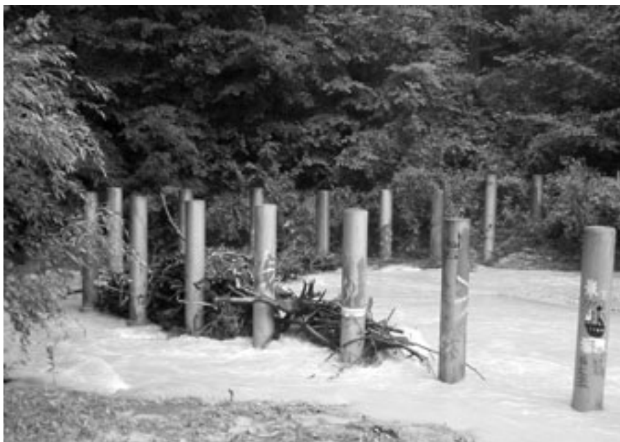
Schwemmholzrechen wie am Kemptenerbach in Wetzikon sind effektive Massnahmen, um Verstopfungen von Durchlässen zu verhindern.
