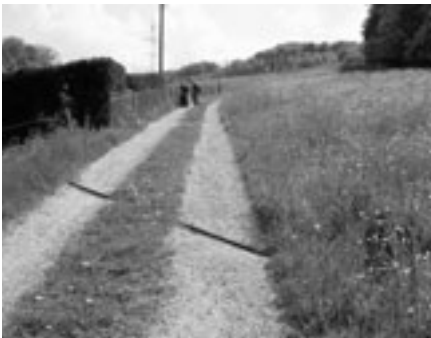
Grasstreifen und Querabschläge (Wasser-rinnen) verhindern Ausschwemmungen an einem Kiesweg.
