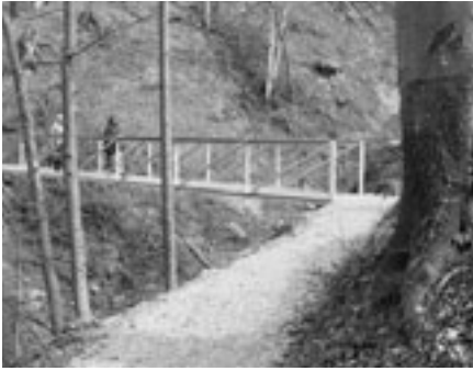
Nach einem Unwetter wiederhergestellter Guyer-Zeller-Weg bei Neuthal.
