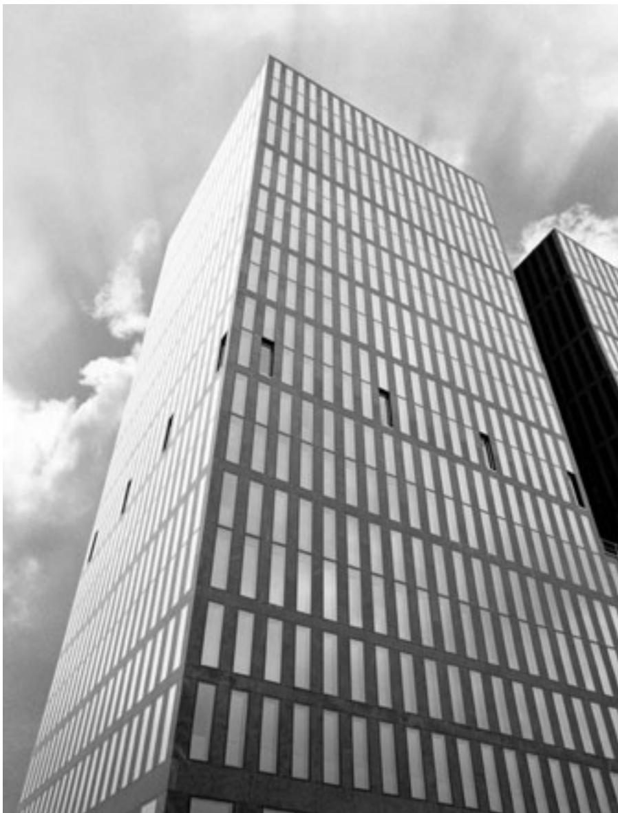
Minergie-Büro mit Aussicht: Das Bürohaus an der Hagenholzstrasse in Zürich-Oerlikon mit einer Energiebezugsfläche von 56 000 Quadratmetern. Das Grossobjekt wurde ebenfalls durch das Hochbauamt des Kantons Zürich realisiert.
