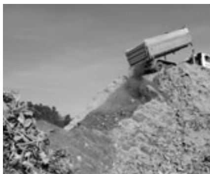
Abfälle aus dem Hoch- und Tiefbau zu rezyklisieren spart Deponieraum.
