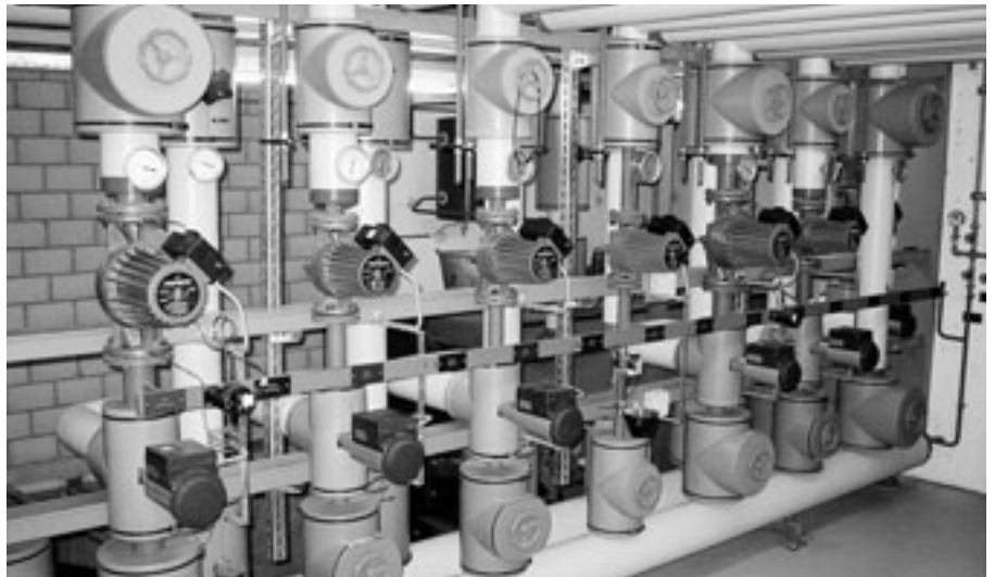
In einigen Fällen gibt die von der Heizzentrale umgesetzte Energiemenge die Systemgrenze vor, meist ist es aber der Stromverbrauch am Elektrizitätszähler.
