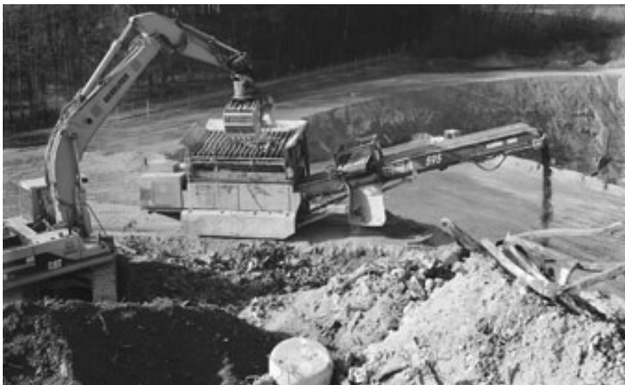
Aus der Verbrennung der Abfälle in den KVA bleiben grosse Mengen an Schlacke zurück, die deponiert werden muss. Deren Qualität kann durch Entschrottung sowie durch weitere Verfahren gesteigert werden.
