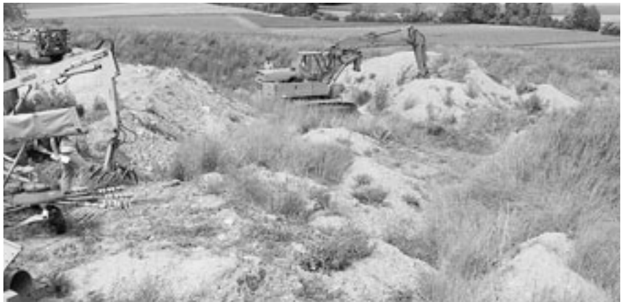
Noch immer wird Bodenmaterial – unter der Bezeichnung «Terrainveränderung» – unerlaubt abgelagert.
