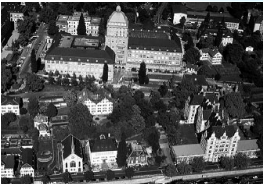
Verbesserte Energieeffizienz durch Betriebsoptimierungen: Die Uni Zürich verfolgt diesen Weg schon seit Jahren.
