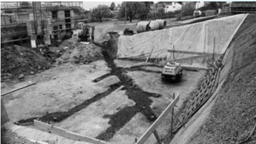
Das Thema Baulärm kann gar nicht früh genug angegangen werden, um verständlichen Unmut von Nachbarn in Grenzen zu halten. Einige einfache Massnahmen können helfen.
