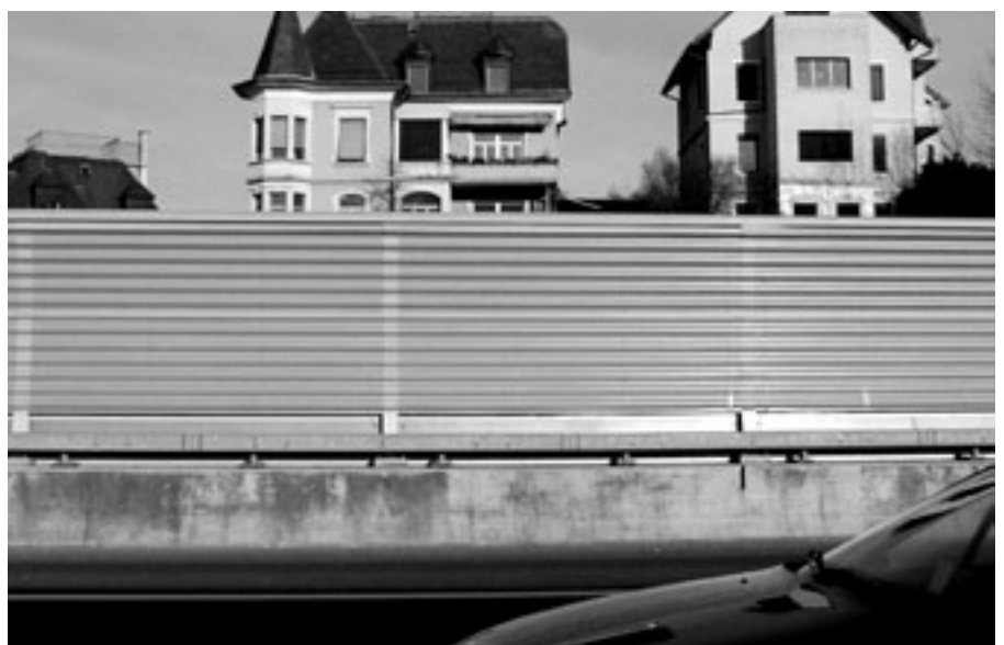
Auch wenn Gestaltung gross geschrieben wird – Hauptanliegen bleibt der Lärmschutz. Lärmpegelreduktionen von bis zu 18 dB (wie hier an der Lessingstrasse) werden allerdings auch an der Zürcher Sihlhochstrasse mit ihren neuen Wänden nicht überall erreicht. Quelle: Aepli
