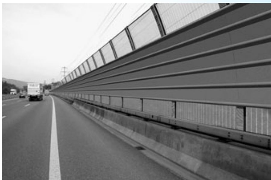
Die Lärmschutzkonstruktionen der neuesten Generation müssen erhöhten Anforderungen gerecht werden – Erscheinungsbild, Platzmangel, Mitspracherecht sind die Stichworte (Bild: Limmattal, Visualisierung einer projektierten Lärmschutzwand aus Beton, Aluminium und Glas). Quelle: FALS
