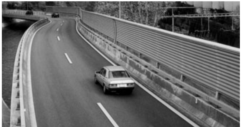
Bei der Zürcher Sihlhochstrasse sollte laut Gestaltungskonzept unter anderem die «ingenieurtechnische Würde des Hauptbauwerkes» erlebbar bleiben. Mit transparenten «Kommunikationsfugen» auf halber Höhe wurde ausserdem die Möglichkeit für Ein- und Ausblicke geschaffen. Quelle: FALS
