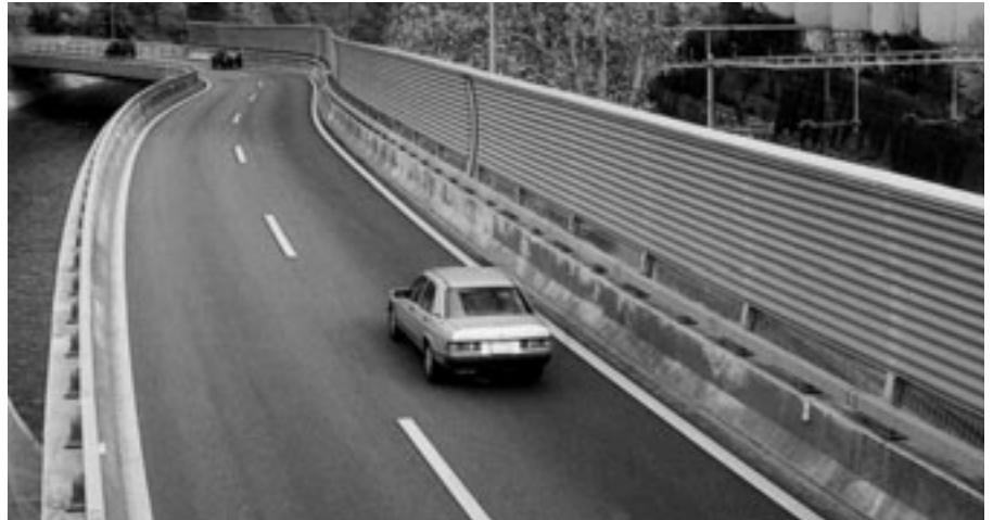
Bei der Zürcher Sihlhochstrasse sollte laut Gestaltungskonzept unter anderem die «ingenieurtechnische Würde des Hauptbauwerkes» erlebbar bleiben. Mit transparenten «Kommunikationsfugen» auf halber Höhe wurde ausserdem die Möglichkeit für Ein- und Ausblicke geschaffen. Quelle: FALS
