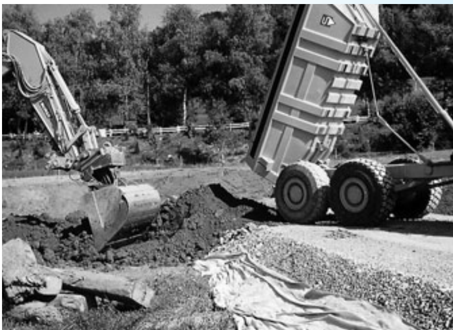
Druckverteilende Massnahmen wie Baggermatratzen oder Kiespisten (im Bild) schonen die Bodenstruktur.
