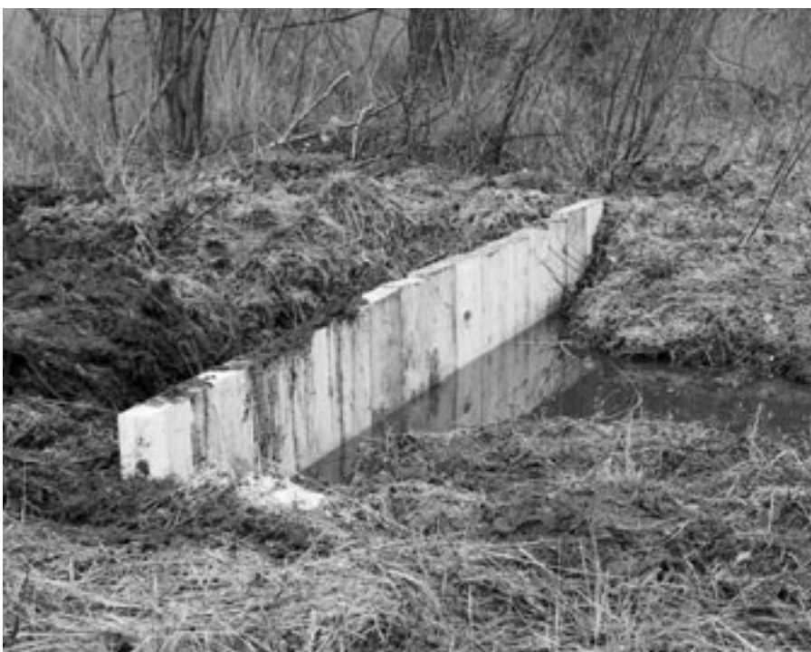
Die eingerammte Holzspundwand wird noch mit Torf teilverfüllt und überdeckt.
