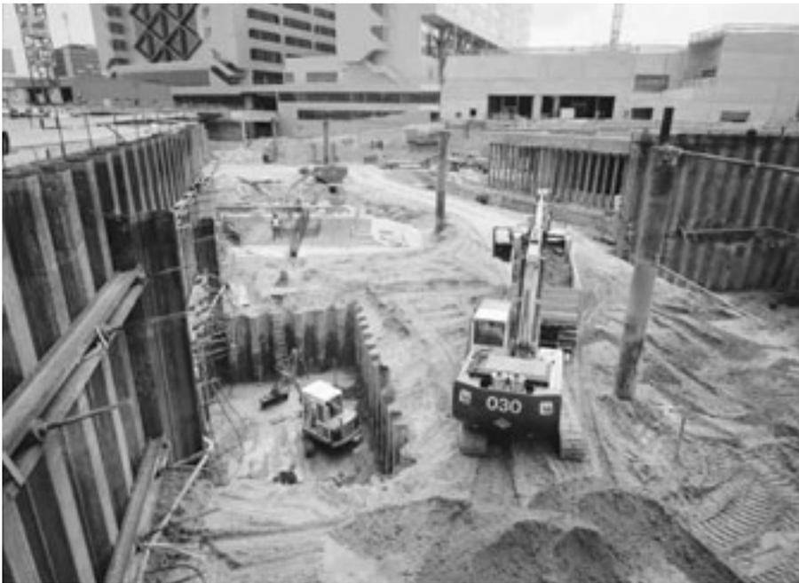
Baumaschinen ab 50 kW Leistung müssen beim Flughafen ausgebaut mit Partikelfiltern ausgerüstet sein (rechts im Bild), kleinere Maschinen benötigen keine Partikelfilter (links). Der Nachtrag 2002 zum Luft-Programm und die Baurichtlinie Luft des BUWAL sehen auch für diese Maschinen und Geräte – mit abgestuften Übergangsfristen – künftig die Partikelfilterpflicht vor (Baurichtlinie Luft ab 18 kW).
