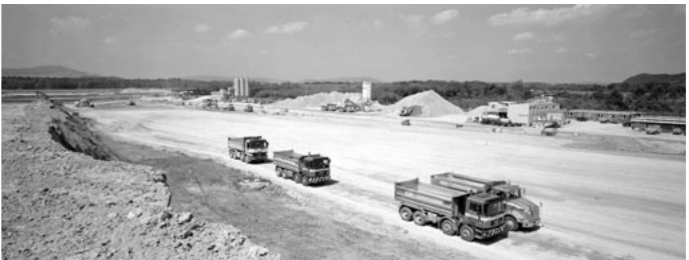
Aushubdepots wie hier im Midfield ermöglichen es zusammen mit der zentralen Materiallogistik, Transporte von und zu den Materialentnahmestellen und zu anderen Baustellen optimal zu kombinieren. Damit können Leerfahrten vermieden und die Transportemissionen gesenkt werden.
