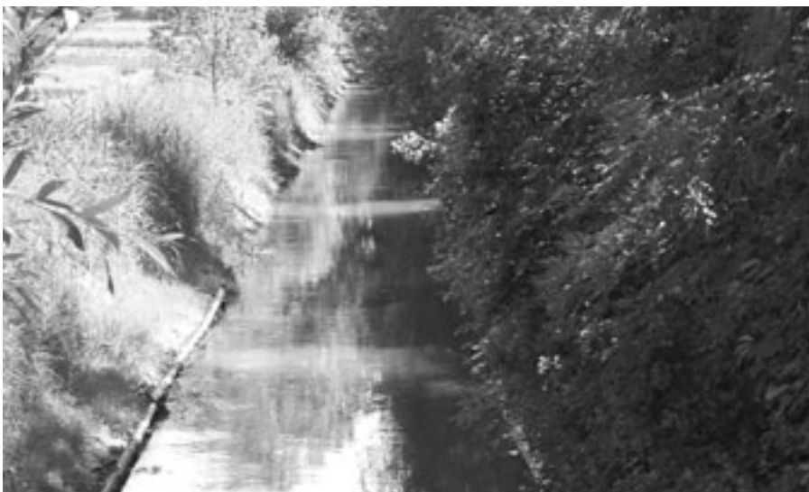
Im Jahr zuvor war der Aarekanal nicht nur sanierungsbedürftig, der gerade Kanal hatte auch nur geringen ökologischen Wert.
