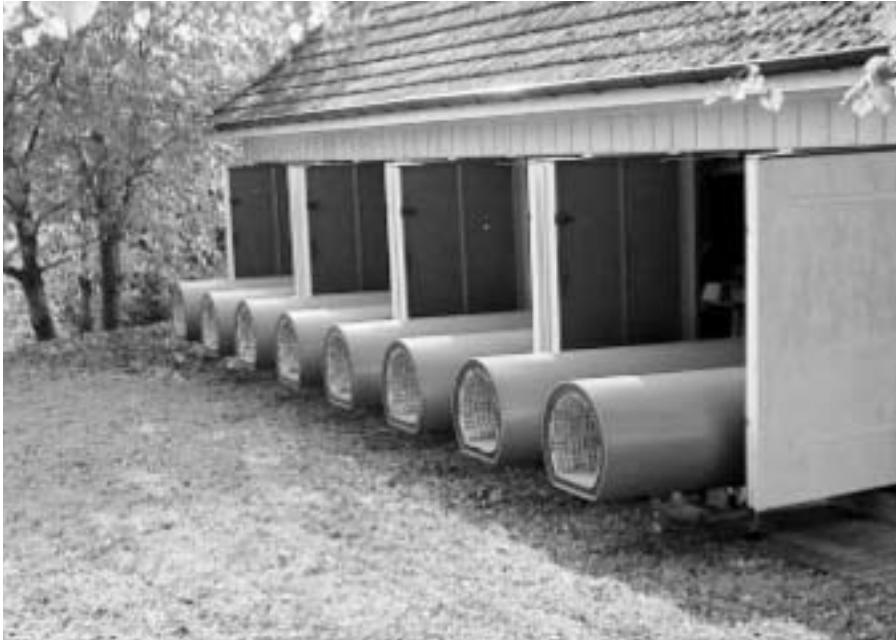
Schiessstunnels bewirken eine massive Reduktion des Mündungsknalls.
