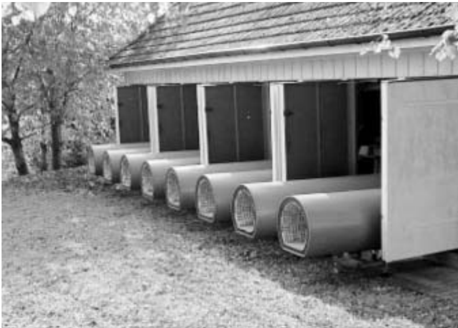
Schiesstunnels bewirken eine massive Reduktion des Mündungsknalls.
