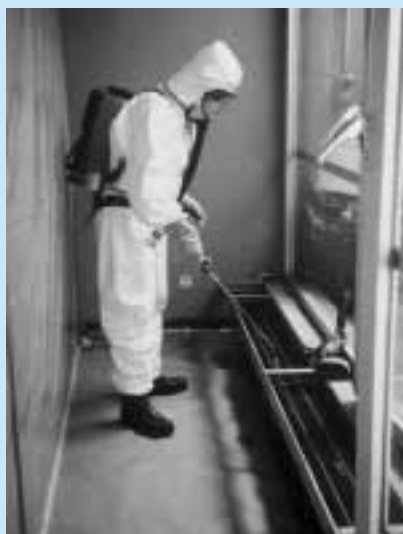
Alle Flächen werden nach Ausbau des belasteten Materials trocken und nass gereinigt. Quelle: ARGE Achermann AG
