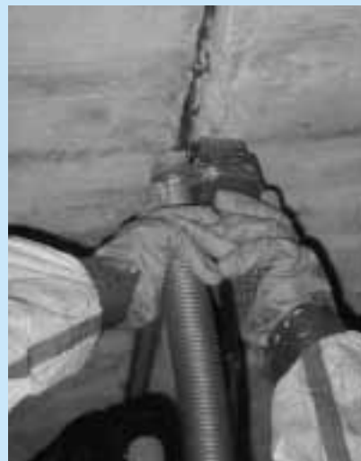
Herausschneiden vom belasteten Fugendichtungsmaterial. Das Absaugen vor Ort verhindert, dass PCB in die Raumluft gelangt. Quelle: A. Binz-Deplazes
