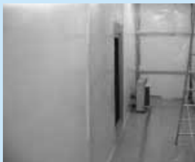
Der Arbeitsbereich wurde vom übrigen Raum abgetrennt. Die Luft wurde über Spezialfilter ins Freie abgesaugt. Quelle: ARGE Achermann AG
