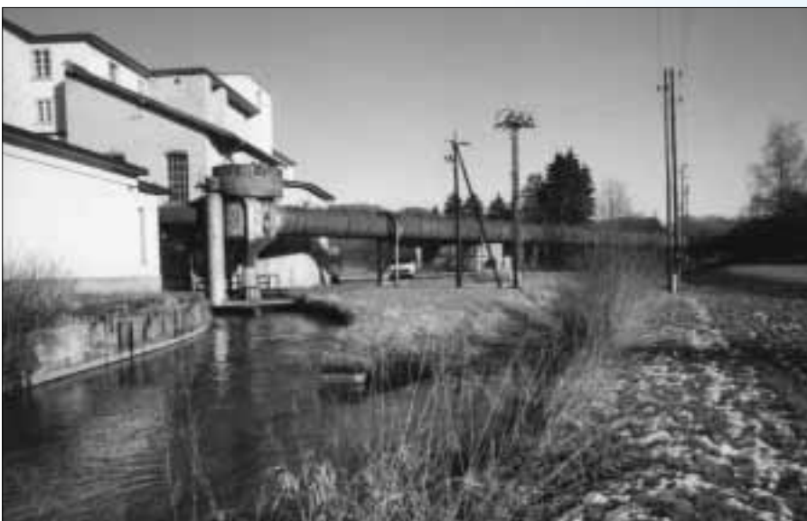
Kleinwasserkraftwerke finden sich häufig in alten Industriegebäuden. Das Elektrizitätsmarktgesetz unterstützt Anlagen, die Strom aus erneuerbaren Energien erzeugen.
