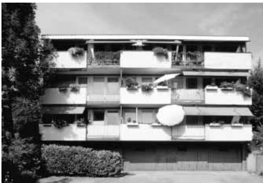
Ansicht des Mehrfamilienhauses in Männedorf vor der Sanierung ...
