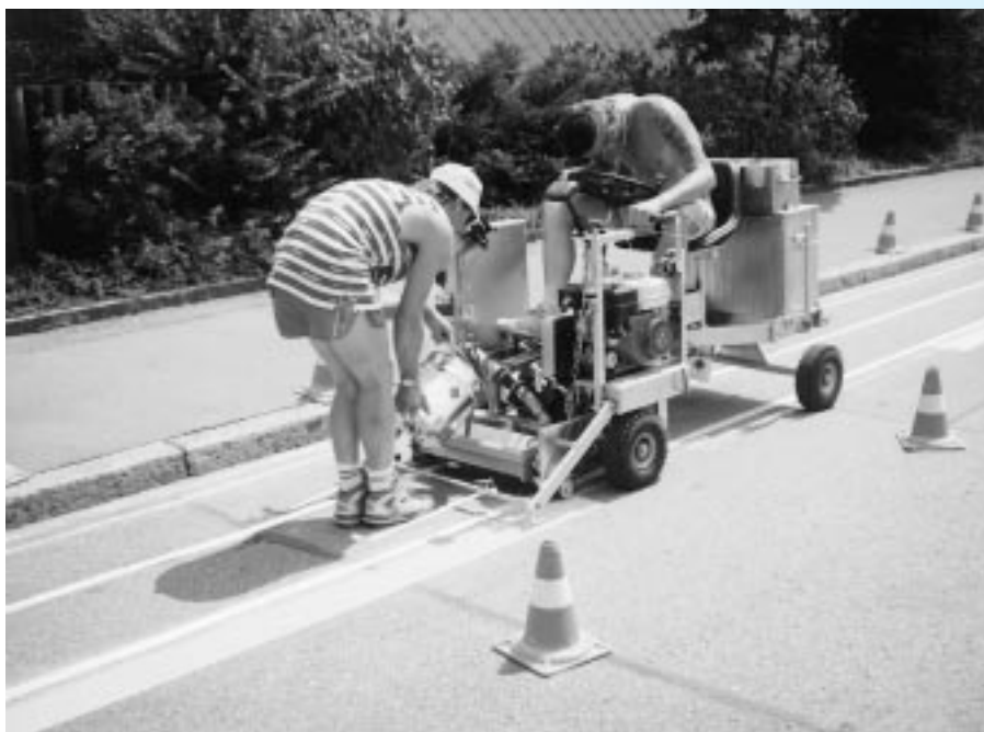
Strassenmarkierungen mit 2-Komponenten-Kaltplastik verursachen im Vergleich mit herkömmlichen Verfahren sehr geringe Lösemittel-Emissionen.
