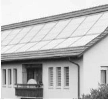
Auf dem Dach der Alterswohnungen in Rheinau wurden 1997 97,5 m 2 Sonnenkollektoren für eine Warmwasseranlage installiert.
