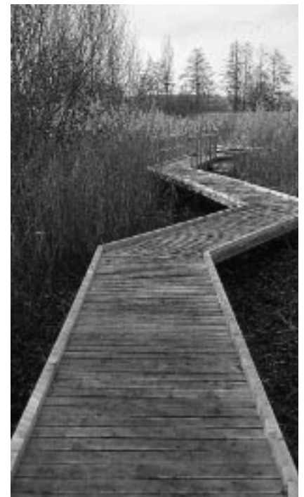
Einer der Stege, über den die Besucher des Naturschutzzentrums durch das Ried zu den Beobachtungshides gelangen.
