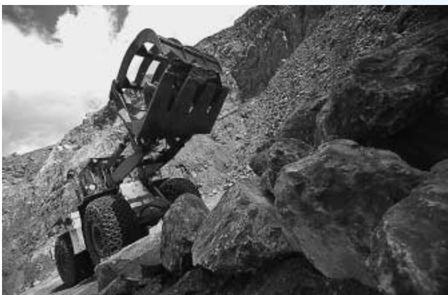
Im Steinbruch der Kalkfabrik Netstal werden nach der Sprengung die Steine sortiert
