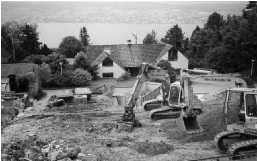
Kontaminierte Böden müssen – zum Beispiel vor einer Neuüberbauung – mit hohem Aufwand entsprechend den Kontaminierungskategorien separiert und dann vorschriftsgemäss entsorgt bzw. in geeigneten Deponien endgelagert werden.
