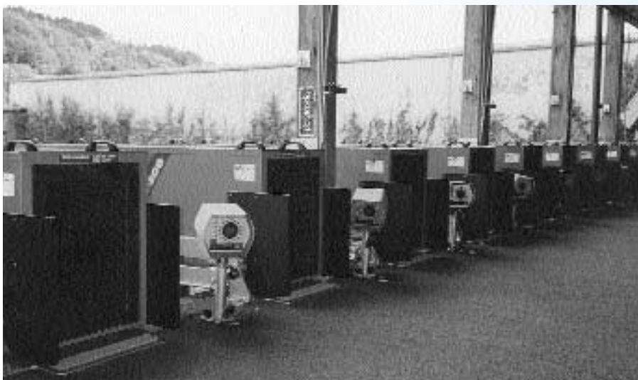
Abb. 1: Lärmschutztunnels auf den Lägern eines Schiessstandes
