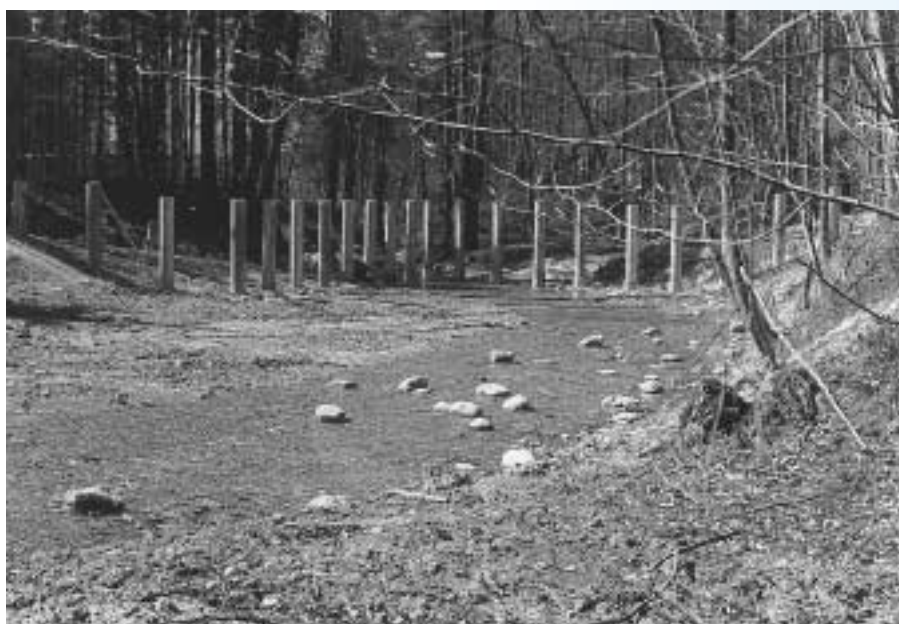
V-förmiger Treibholzfang Chämtnertobel, gebaut im Winter 1996/97: Aufgenommen kurz nach Beendigung der Bauarbeiten
