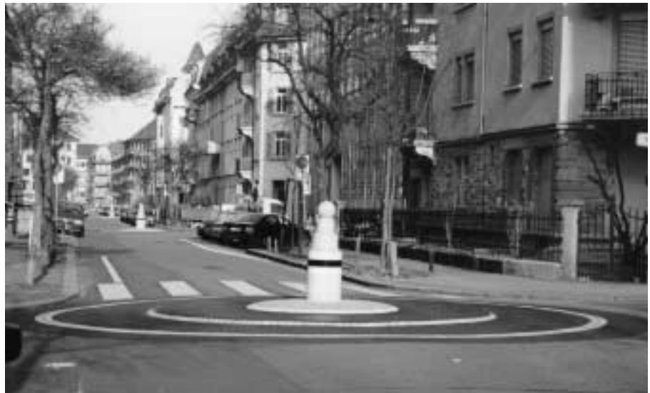
Abb. 1: Zypressenstrasse nach Einführung von Tempo-30: Rosette («Minikreisell») mit vorfabriziertem Betonpfosten; der innere Teil der Rosette ist gegenüber dem Strassenniveau leicht erhöht, aber nicht in dem Masse, dass von einer «Schwelle» gesprochen werden könnte. (Foto AGU, Zürich)
