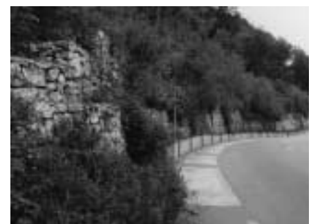
Abb. 4: Das Pflanzenkleid verwischt die eher harten Formen der aufeinander geschichteten Steinkörbe.
