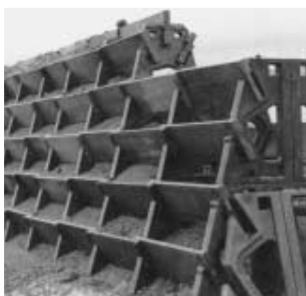
Abb. 3: Das Kunststoffskelett wird zusammengesteckt und mit Erde gefüllt. Die Pflanzen machen daraus eine grüne, absorbierende Lärmschutzwand.
