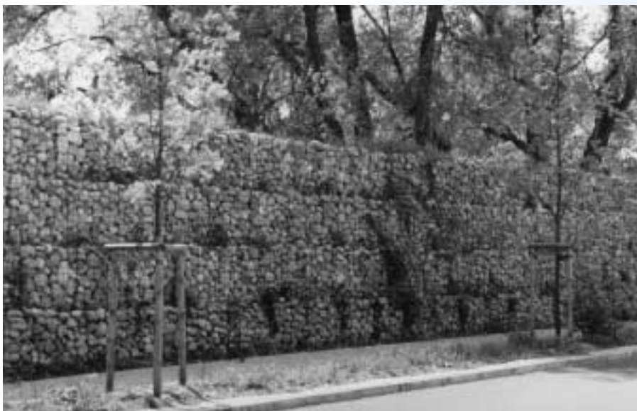
Abb. 1: Neuere Lärmschutzwand aus Steinkörben. Bereits wachsen zwischen den Steinen die ersten Pflanzen.
